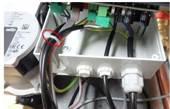
3. Desconecte el conector de la válvula antigua de la electrónica de la tapa.
