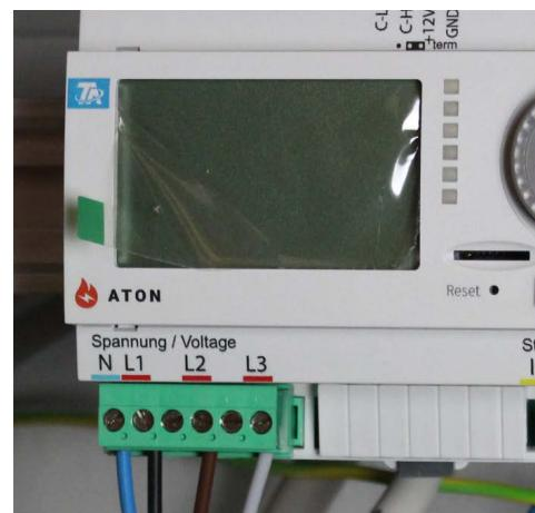
Diese Leitung muss abgesichert werden. Der Energiezähler selbst muss nicht abgesichert werden.
