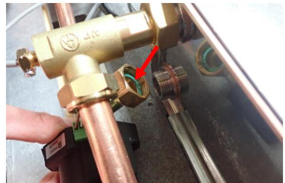
7. Fertig montiertes Ventil:
