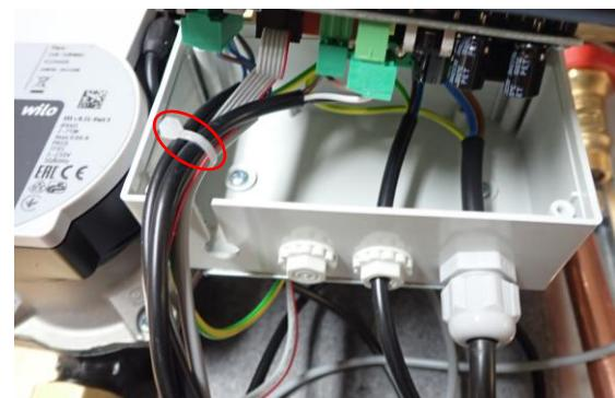
3. Débrancher le connecteur de l'ancienne vanne de l'électronique de couverture.
