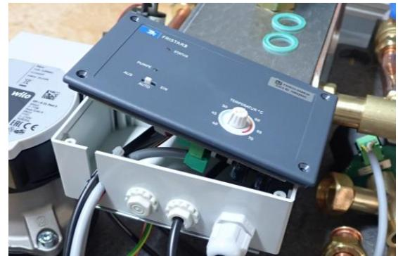
6. Poser de nouveaux joints. Visser les écrous de serrage qui remplacent les raccords à vis hollandais.
